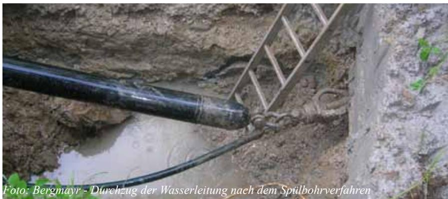
Foto: Bergmayr - Durchzug der Wasserleitung nach dem Spülbohrverfahren
