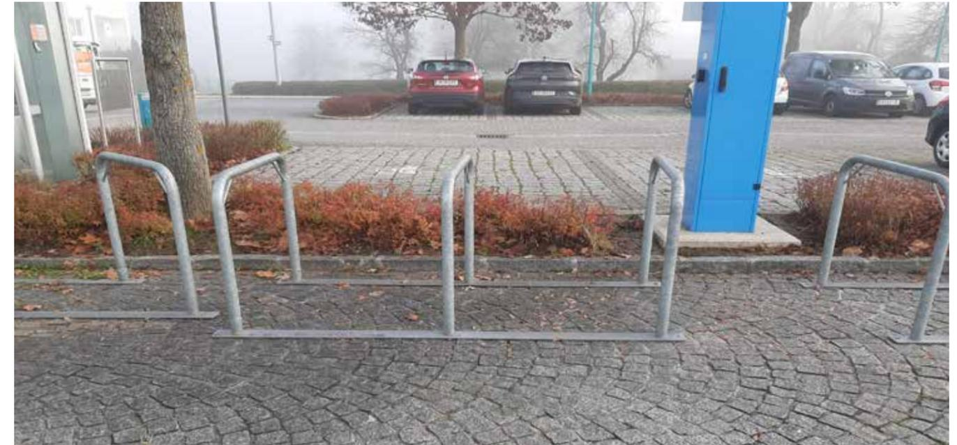
*Technisch beste Lösung für Fahrradabstellanlagen: Bügel mit ausreichend Abstand für zwei Fahrräder*
